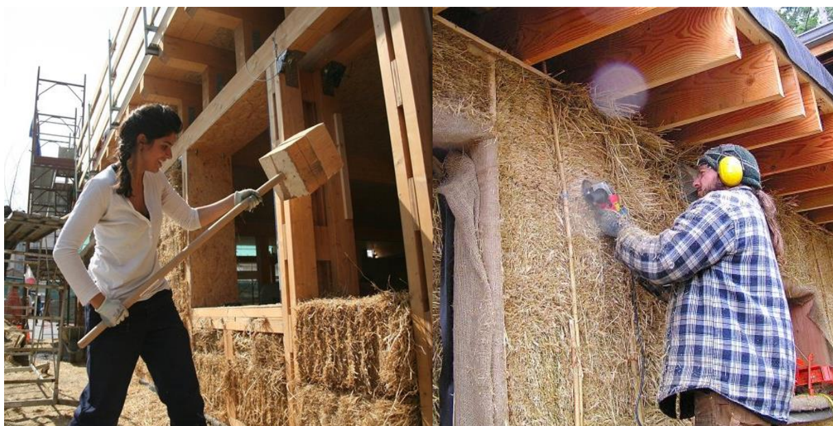
Рис. 5. Кладка и выравнивание соломенных блоков
