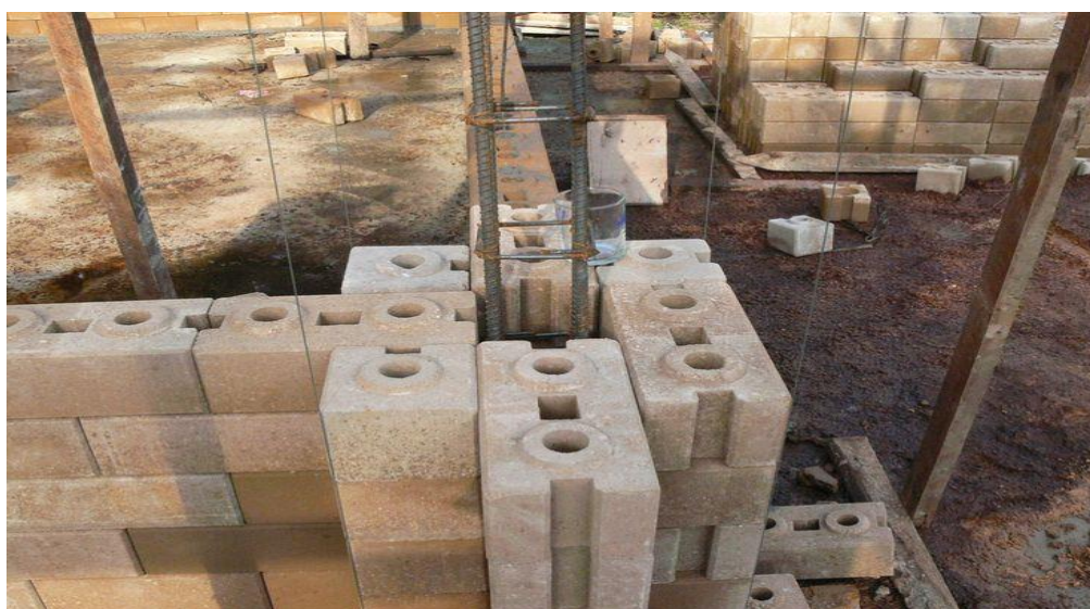
Рис. 9. Вертикальные отверстия в блоках
