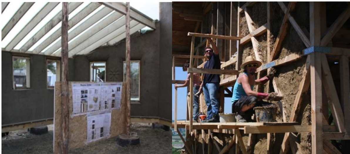
Рис. 6. Штукатурка стен
